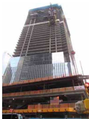
建設中のフリーダムタワー
